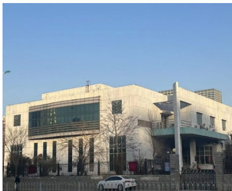
图7 芥园道 220kV 变电站现状图
